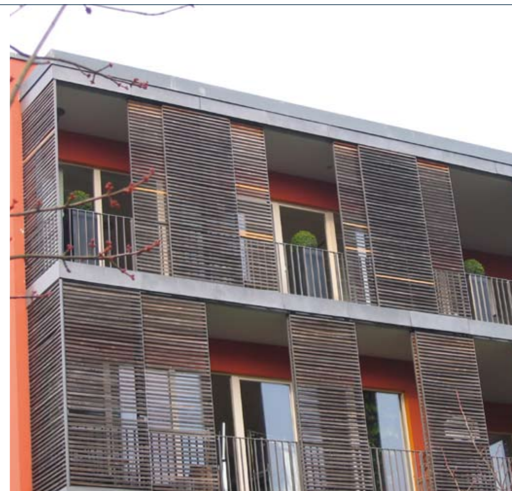
Wohnanlage Zehlendorf, Berlin
