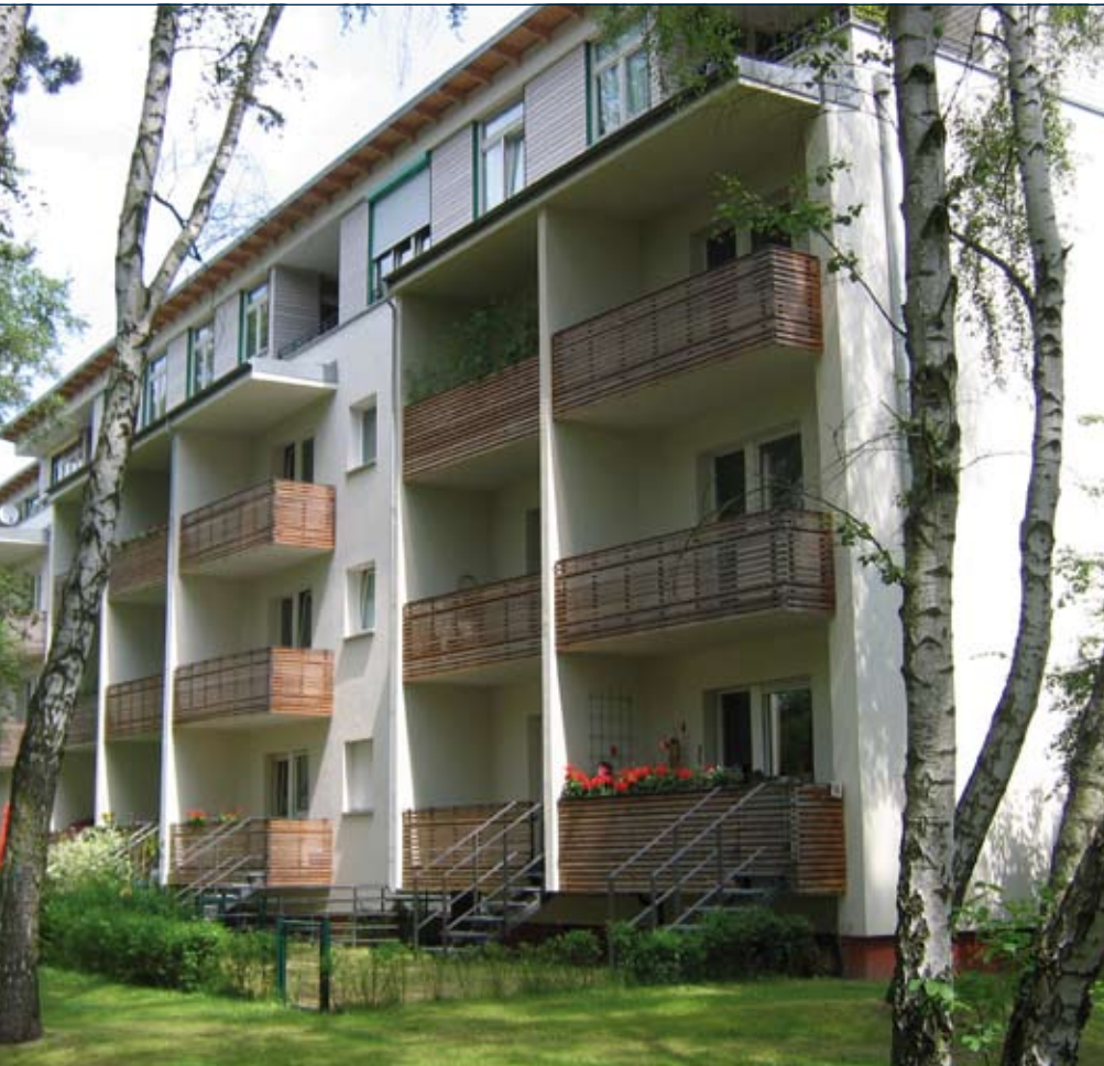
Wohnanlage Zehlendorf, Berlin
